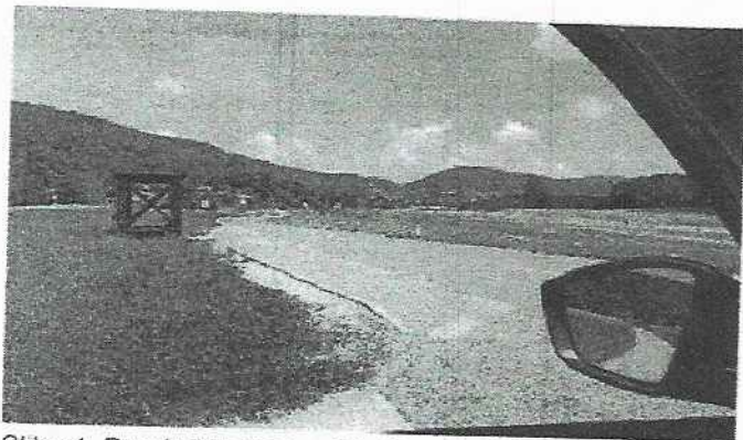
Slika 4: Preglednost na priključku v km 10,835 levo (Črmošnjice) in AP v km 10,810
